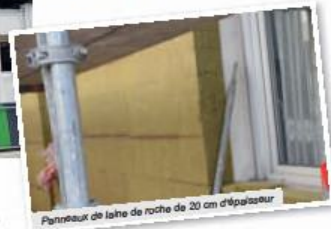
Panneaux de laine de roche de 20 cm d'épaisseur
